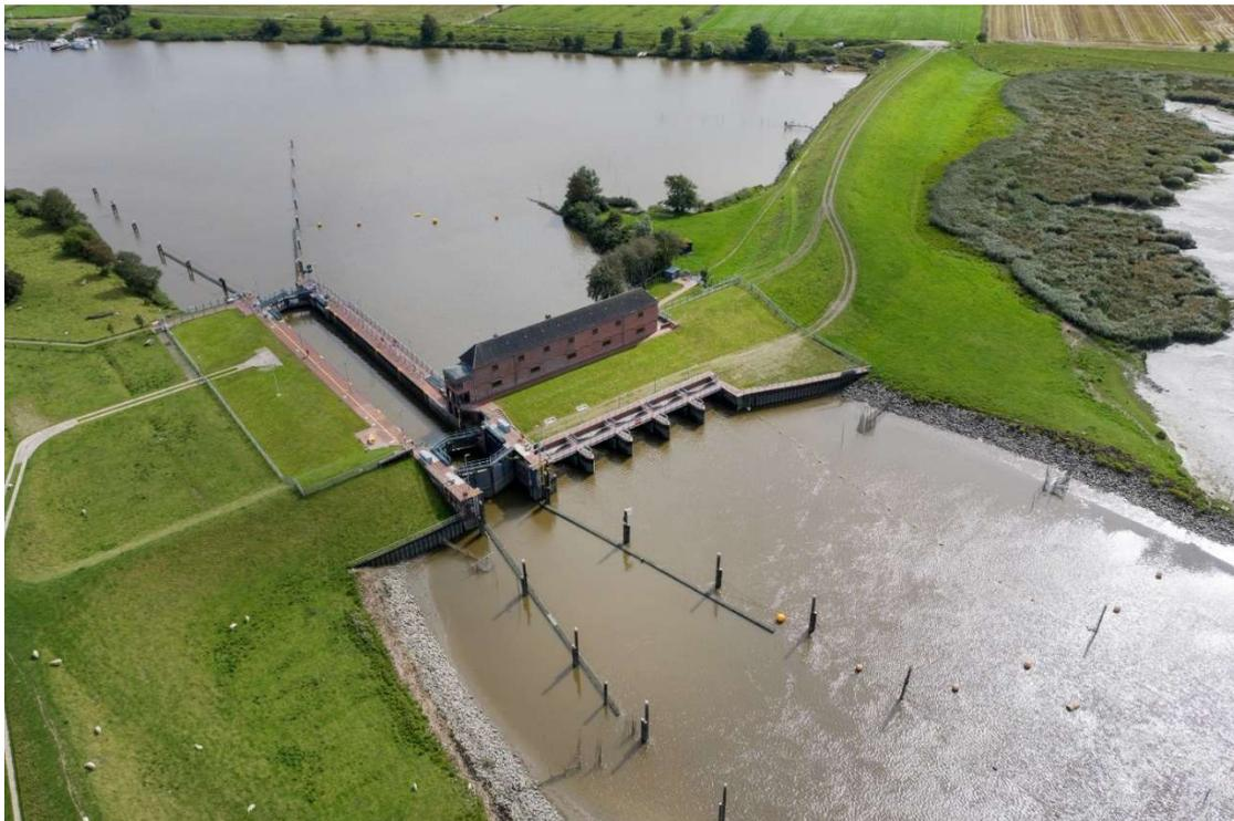
Abbildung 2-17: Schleuse und Wehranlage Nordfeld, Foto © BAW 2019
