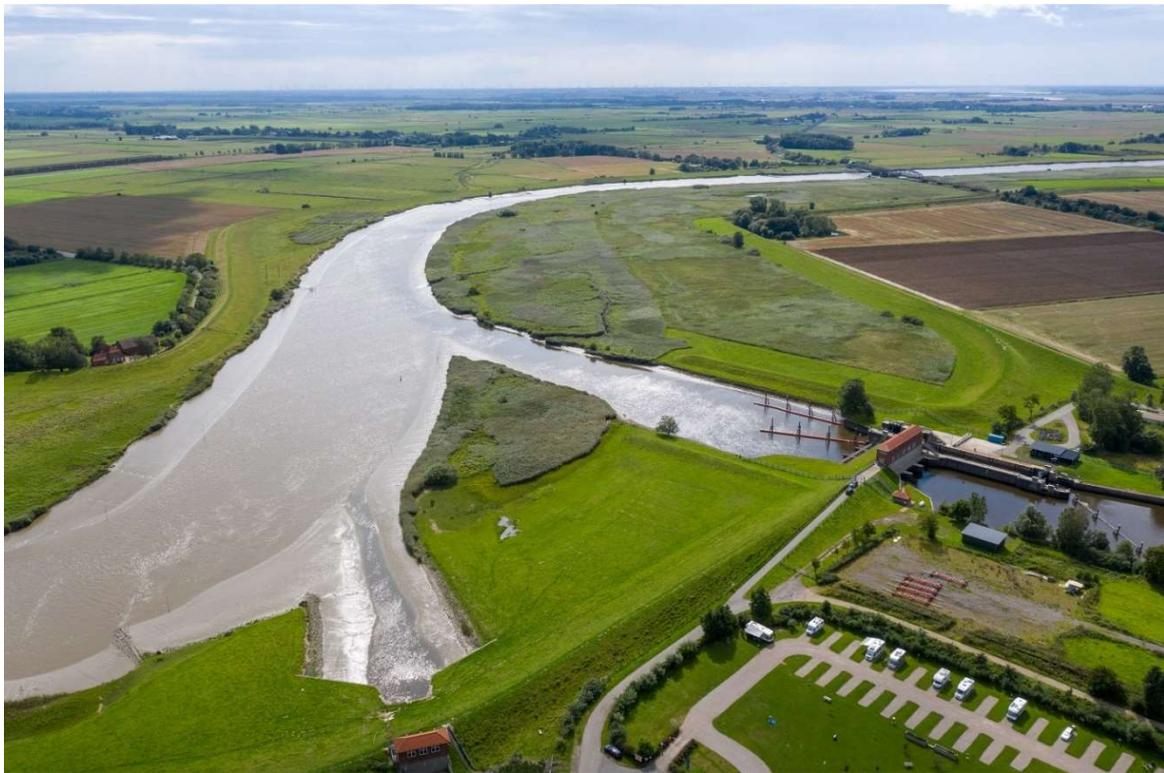
Abbildung 2-18: Schifffahrts- und Entwässerungsschleuse (rechts mittig) und Spülschleuse (links unten) in Friedrichstadt, Foto © BAW 2019
